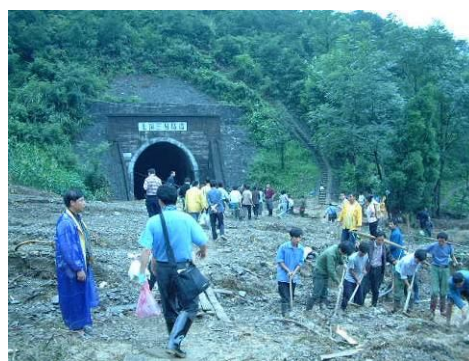
图 5 泥石流淤埋的卓福隧道
